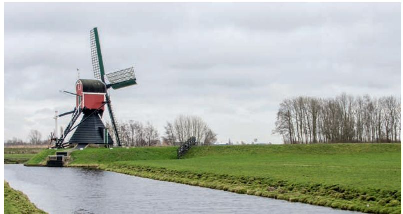
De 17de-eeuwse Kagermolen bemaalt nog steeds de Kaagerpolder.
